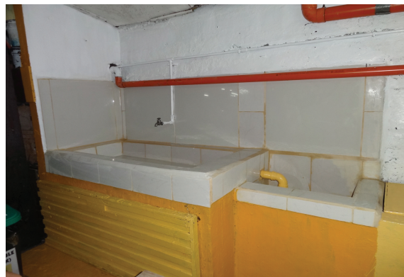
개선후 (폐수처리시설 설치)
