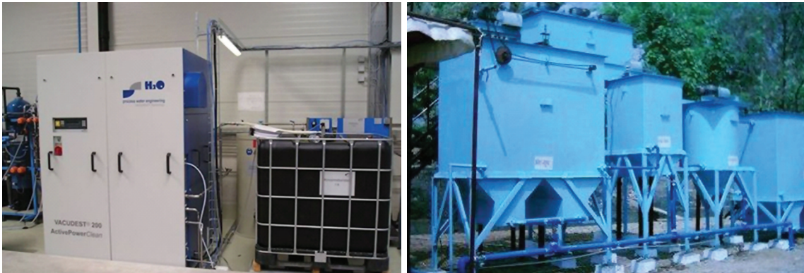
<그림 10> 진공증발농축 무방류 폐수처리시스템(좌)와 응집-침전 폐수처리 설비(우)
